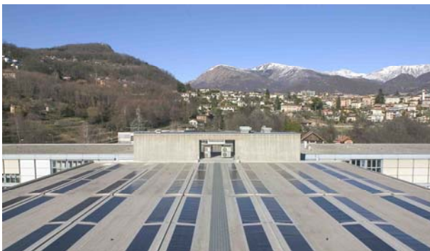
Figura 1: Moduli PV in film sottile, integrati nei manti in poliolefine che svolgono la funzione di sistema di impermeabilizzazione.
